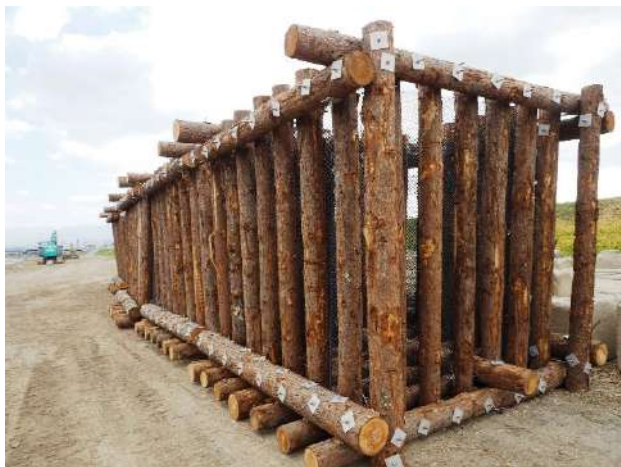
重信川に敷設された木工沈床（床止め） 2017/12
