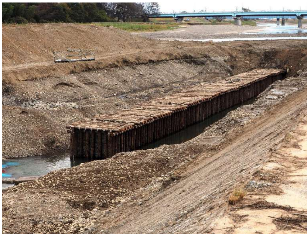
重信川に敷設された木工沈床（床止め） 2017/12
